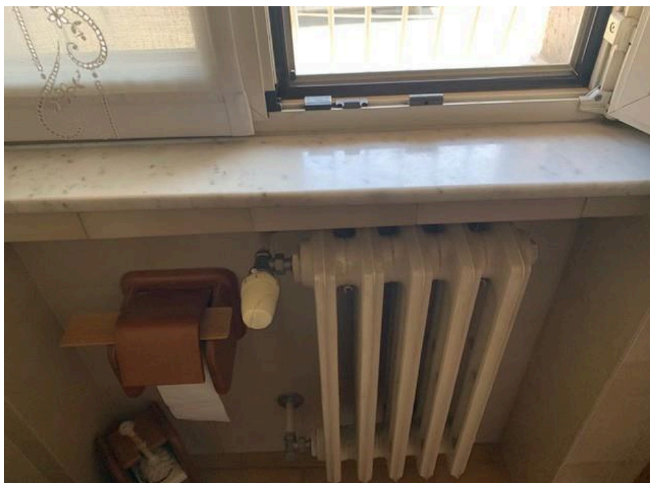
Vista interna - dettaglio serramento/termosifone
